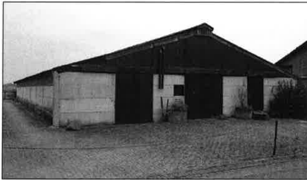
Foto te slopen rundveestal
