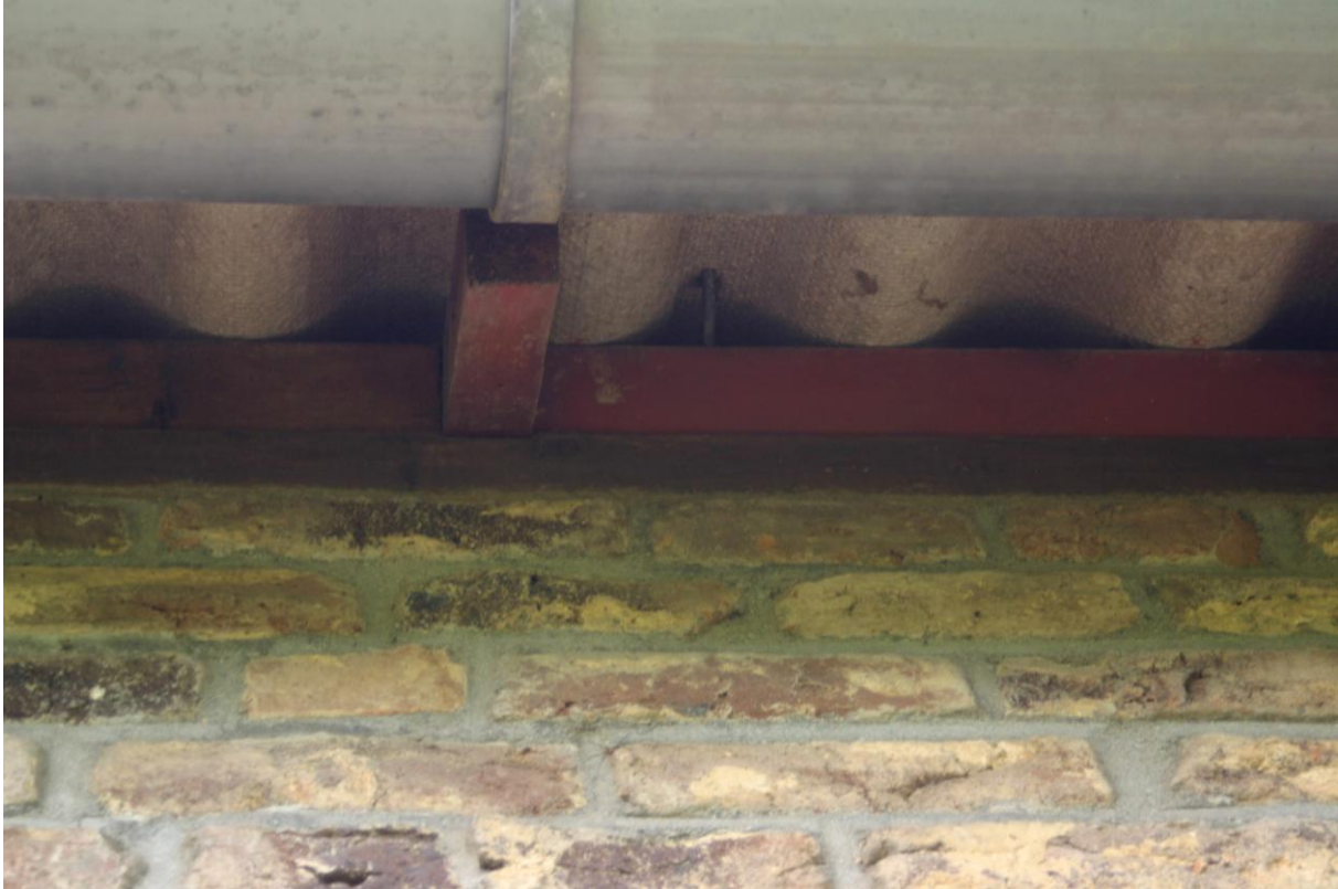
Figuur 4. Zicht op de dakrand vanaf de oostzijde.
