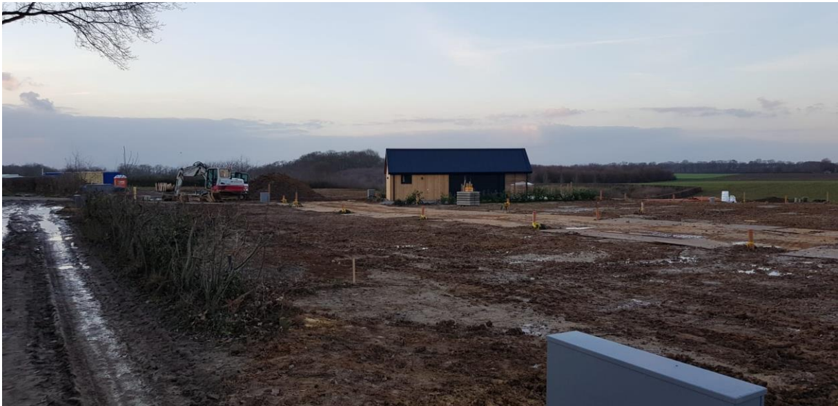
Figuur 1 bouwactiviteit aan de overkant van de weg
