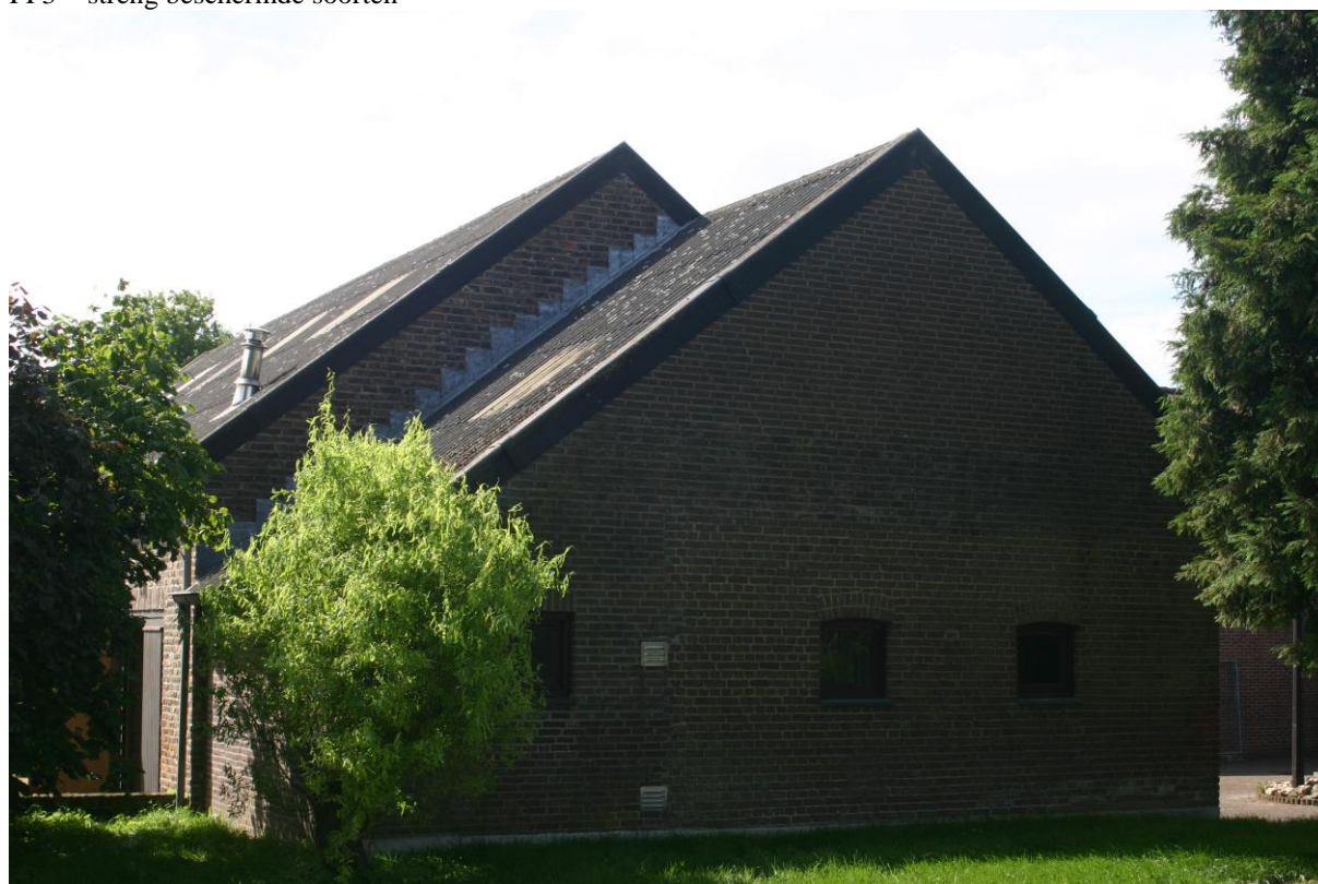
Figuur 3. De te verbouwen loods vanuit het noorden.
