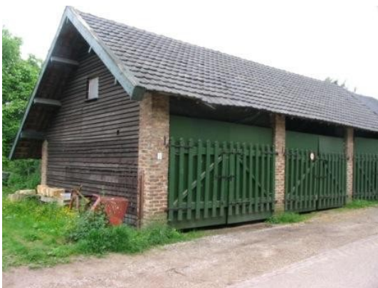
Figuur 6: Aan de wegzijde bevindt zicht een schuur.
